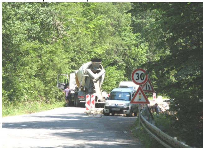
Práce na oprave cesty neďaleko križovatky na Málinec
